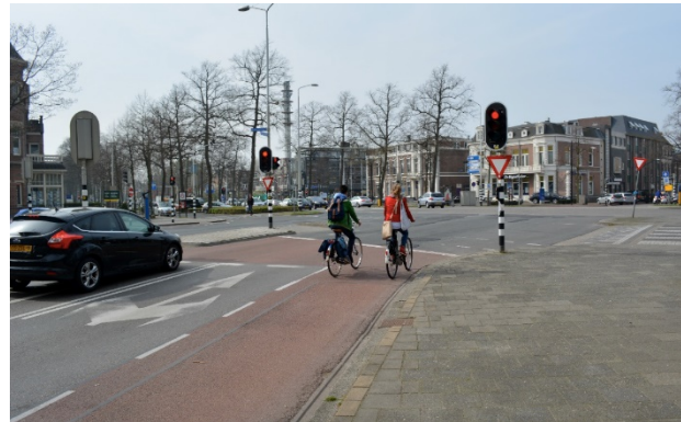
Advance Stop Bar (Bicycle Box)
