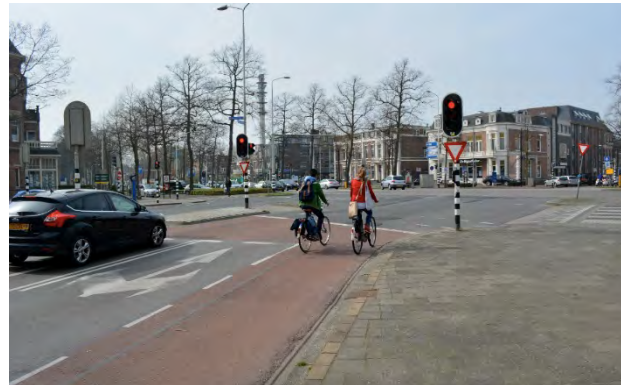
Advance Stop Bar (Bicycle Box)
